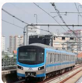
Dự án Metro Bến Thành - Suối Tiên
