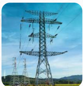
Dự án Đường dây 500kV Quảng Trạch - Phố Nối
